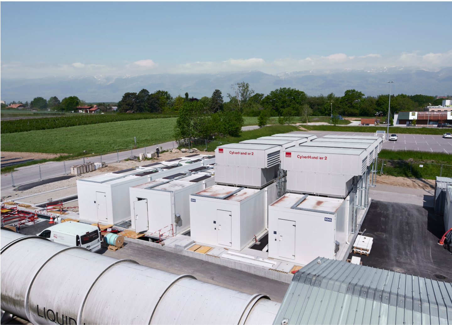
LHCb portable data centre \sim 2 \text{ MWh}
